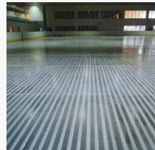
スケートリンク施工例
