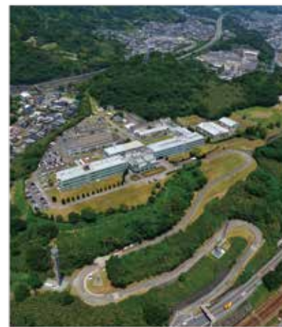
日本軽金属グループ技術センター
